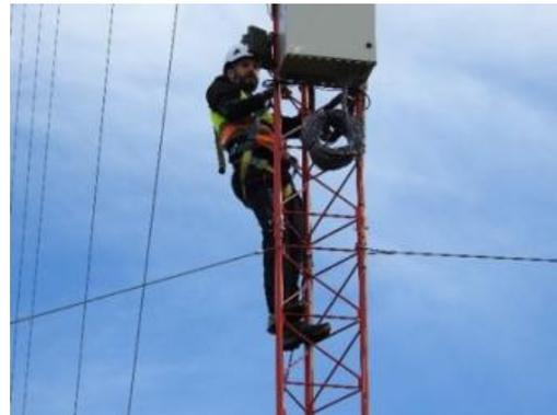
*Figuras 1-2. Detector Wildlife Acoustics® Song Meter SM4BAT-FS® con un micrófono SMM-U2® en la torre meteorológica a una altura dentro del área de barrido de las palas*
