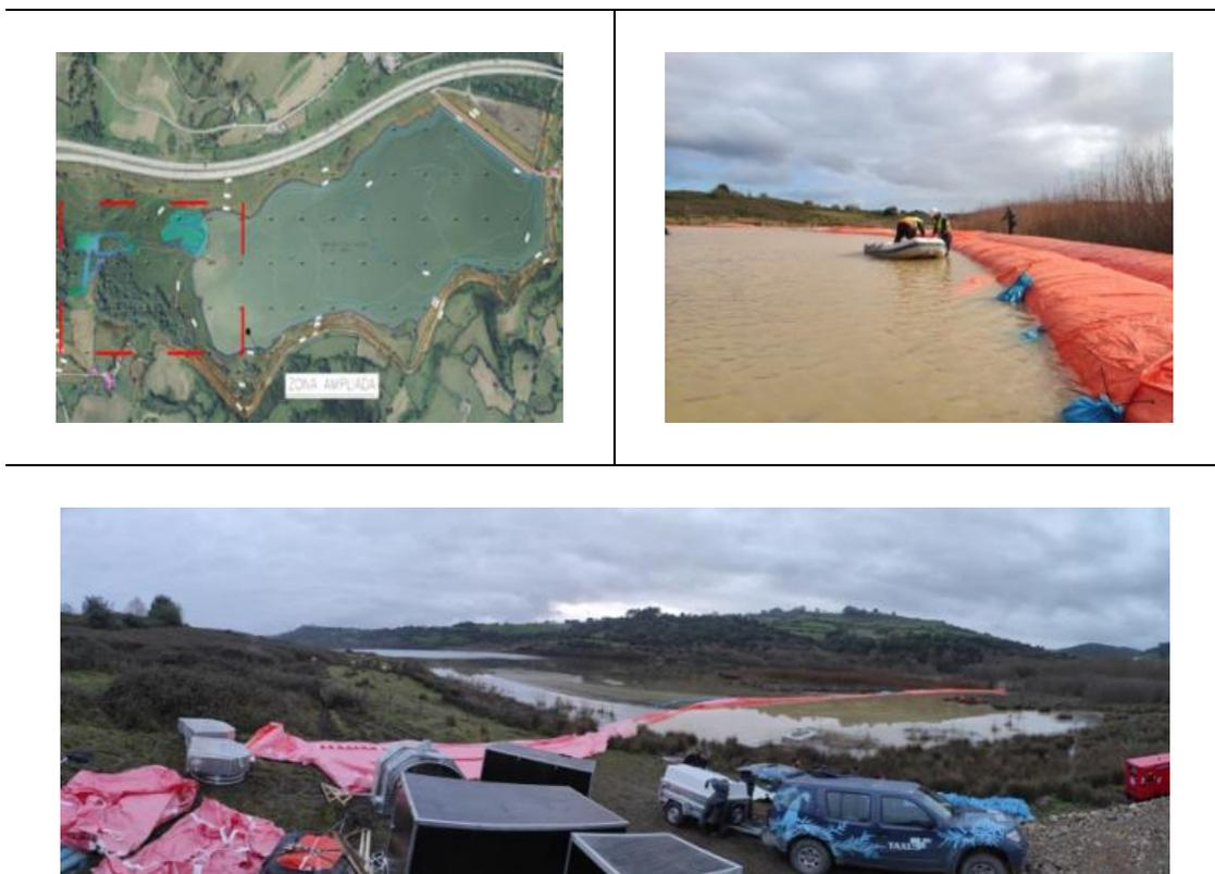
*Figura 18-20. Zona de colocación y proceso de montaje de las barreras hinchables para la creación de la laguna artificial en la cola del embalse de San Andrés de los Tacones.*
