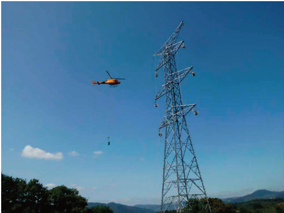
Figura 2. Tendido de la cuerda piloto con helicóptero.
