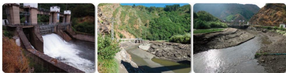
Figura 1. Proceso de vaciado del embalse de Pilotuerto.
