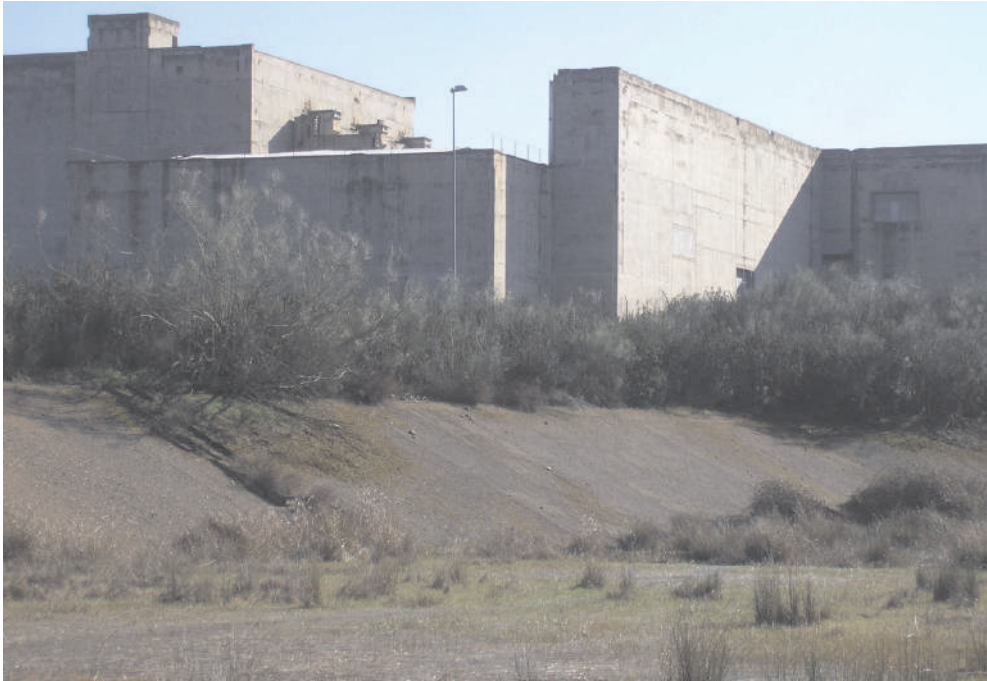
Figura 3. Detalle de las construcciones de la Central y mota del embalse de esenciales. Logicamente el grosor de sus muros y estructuras en general, eran necesarios, pero ahora resultan una complicación al tratar de buscar posibles alternativas de uso.
