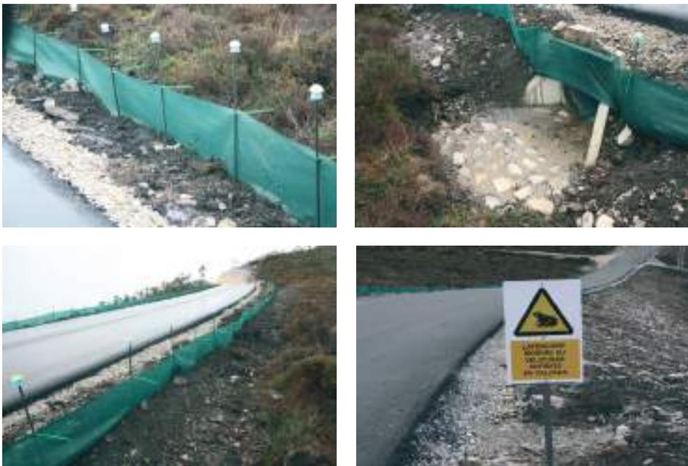
Imagen 3. Distintos detalles de la valla ya colocada.
