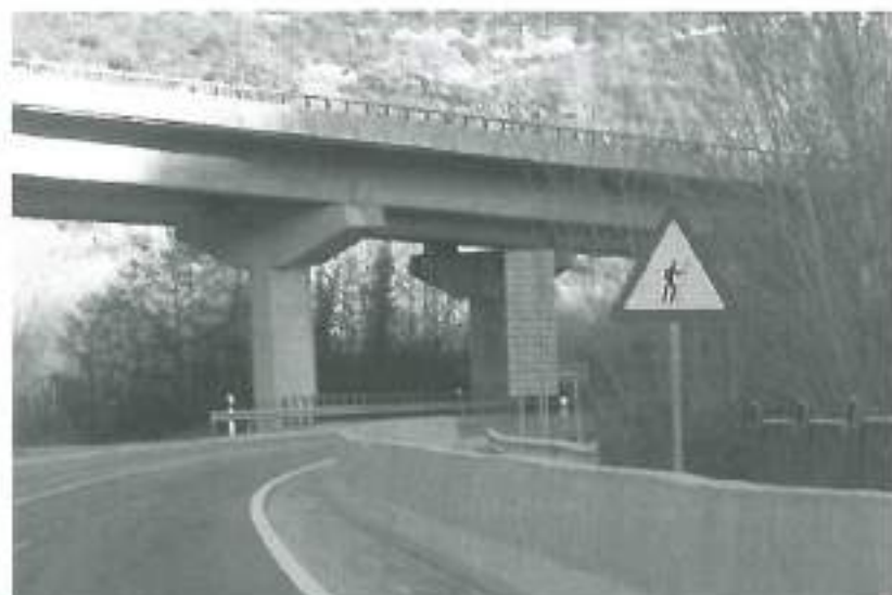
Figura 3. El trazado de la carretera nacional N-11 impide la función de paso de fauna de los viaductos de la autovía A-6.
