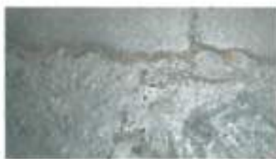
Fotos de interior de tanque en uso donde se aprecia la corrosión interna
