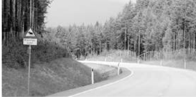
Figura 6. Empleo de cerramientos perimetrales
