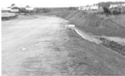
Figura 3. Acopio de tierra vegetal en cordones junto a la plataforma de un tramo en obras de la Autovía del Cantábrico A-8 (Asturias)
