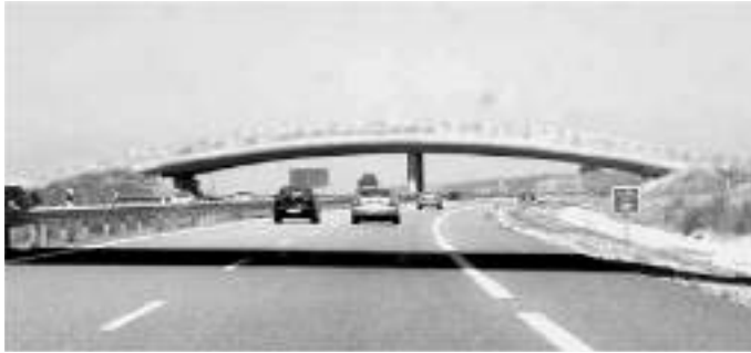
Figura 2. Paso de fauna específico en la autovía A-66 (León), el terreno llano obliga a diseñar un paso superior tipo arco, dificulta la visión hacia el otro lado
