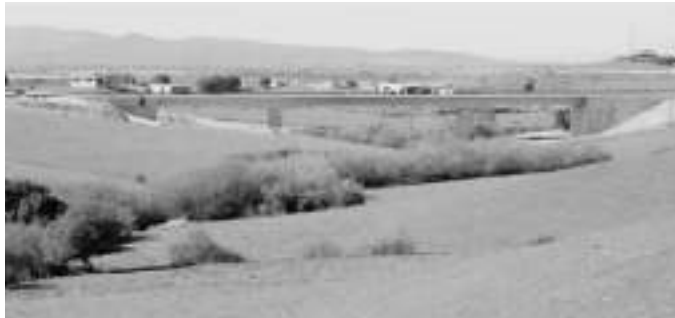
Figura 4. Viaducto de la LAV Madrid-Valladolid en Madrid, funciona como un paso de fauna mixto. Permite el paso de un arroyo, un camino rural y el de la fauna
