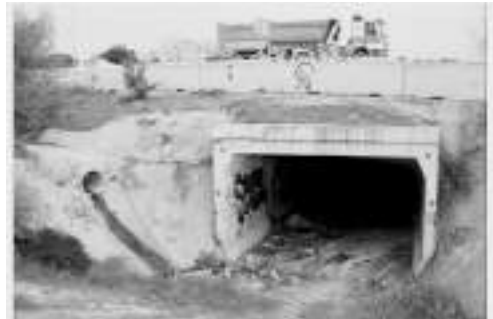
Figura 5. Autovía M-607 (Madrid, carretera convencional desdoblada). Obsérvese: rampas pronunciadas, nulo campo de visión, interrupción del drenaje longitudinal y medidas drásticas para estabilizar taludes
