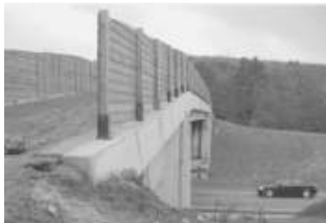
Figura 3. Paso de fauna específico. Aprovechando un tramo en desmonte de la carretera SO-830 (Soria) se minimiza la pendiente en las rampas de acceso al paso y la pérdida de visibilidad hacia el otro lado
