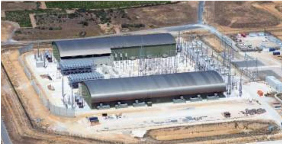
Estación convertora Baixas (Francia).
