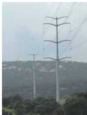
Figura 3.3. Diferentes tipos de apoyos utilizados en las líneas de alta tensión.
