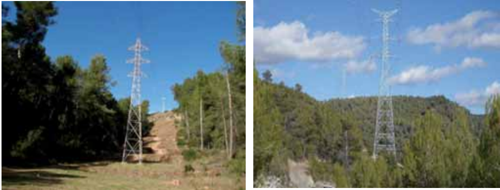
Figura 3.1. Afectación territorial directa de una línea eléctrica, incluyendo su correspondiente impacto paisajístico (izquierda) y afectación paisajística en la línea de 400 kV Sentmenat-Vic-Bescanó (derecha). En el segundo caso la afectación territorial en términos físicos es muy limitada, puesto que no se altera la vegetación bajo el tendido, sino únicamente en los puntos donde se asientan los apoyos. La contrapartida de esta menor afectación es una mayor altura de las torres, lo que conlleva mayor visibilidad.
