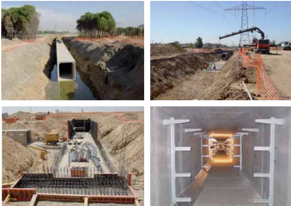
Figura 3.6. Construcción de la línea soterrada de 400 kV entre San Sebastián de los Reyes y Loeches (durante las obras, 2003).
